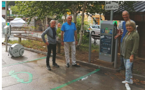
Installation de bornes électriques pour voitures
