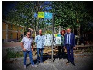
Borne de recharge vélos électriques installée au Square AFN
