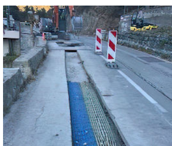
Assainissement du quartier Pessigaud (Régie de l'eau)
