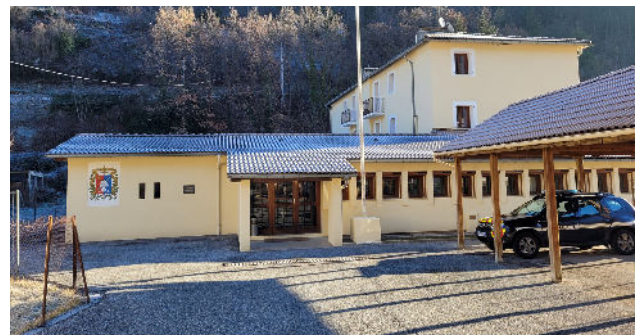
Rénovation de la Gendarmerie de Guillaumes
