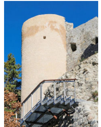
La passerelle du château est posée
