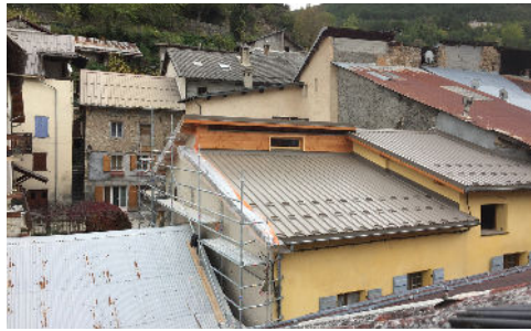
Rénovation de la toiture du musée
