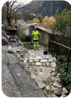
Rénovation du chemin du Château en régie par nos agents
